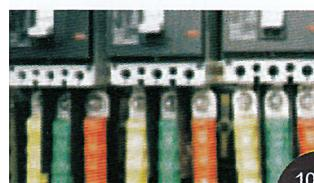
10. 连接前应使用绝缘套管或
