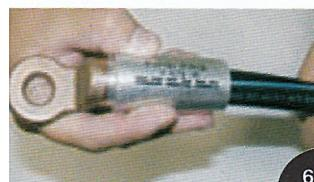
6. 将电缆插入压缩式接头，注
